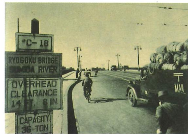
1947(昭和22)年の両国橋。GHQの占領下にあった当時は、英語の道路標識が溢れていた。
